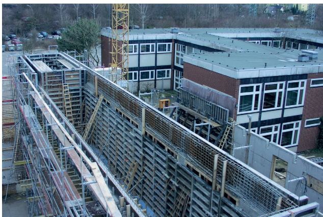
i2003 befindet sich die Aula im Bau – endlich!
